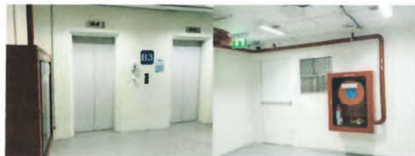
ลิฟต์ดับเพลิงมีตู้หัวฉีดน้ำดับเพลิงและระบบอัดอากาศป้องกันควันไฟ
