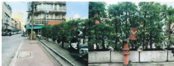
อาคารติดตั้งหัวรับน้ำดับเพลิงเดินเข้าระบบท่ออื่น ด้านข้างอาคาร
