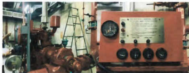
อาคารติดตั้งเครื่องสูบน้ำดับเพลิงเครื่องชนิด 1 ชุด และจ็อกกิ้งบีม 1 ชุด
