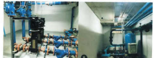
อาคารติดตั้งเครื่องสูบน้ำใช้ จำนวน 3 ชุด ที่ชั้นใต้ดิน และ บั๊ตเตอร์ปั๊มที่ชั้น 10
