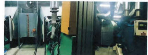
อาคารติดตั้งเครื่องกำเนิดไฟฟ้า ขนาด 1650 kVA 1 ชุด และ 250 kVA 2 ชุด ชั้น 7M
