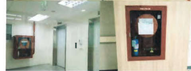
อาคารติดตั้งตู้หัวฉีดดับเพลิง ท่อ Host reel 1 นิ้ว ครอบคลุมพื้นที่ทุกชั้น
