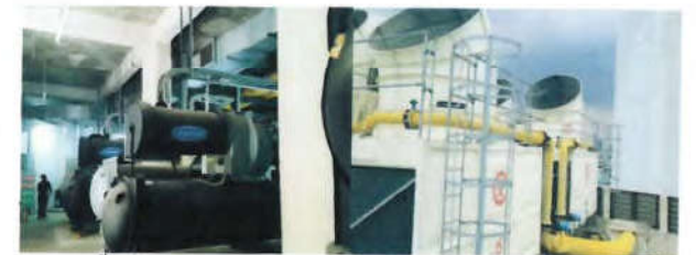
อาคารติดตั้งระบบปรับอากาศชนิดศูนย์รวม Water cool Chiller ห้องเครื่องที่ชั้น 9
