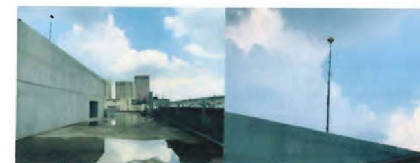
อาคารติดตั้งระบบป้องกันฟ้าผ่าชนิดศูนย์รวมพร้อมสายดินลงสู่ชั้นล่างของอาคาร
