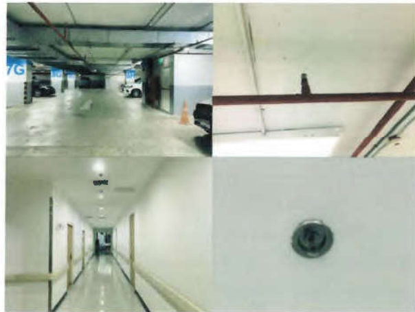
อาคารติดตั้งระบบฉีดน้ำดับเพลิงอัตโนมัติครอบคลุมพื้นที่ทุกชั้น
