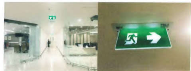
อาคารติดตั้งป้ายไฟฉุกเฉินส่องนำทางหนีไฟที่มองเห็นได้ชัดเจนทุกชั้น
