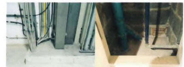
ช่องเดินท่องานระบบไฟฟ้าและประปาใช้วัสดุทนไฟอุดช่องท่อป้องกันไฟลาม
