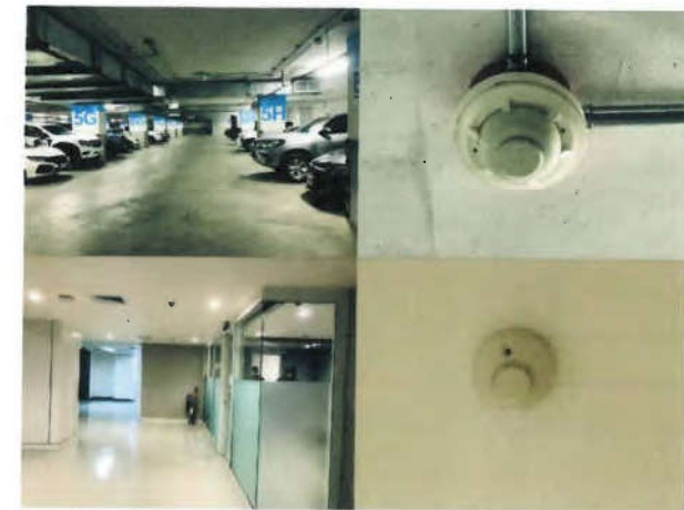
อาคารติดตั้งสัญญาณเตือนเพลิงไหม้ชนิดอัตโนมัติครอบคลุมพื้นที่ทุกชั้น
